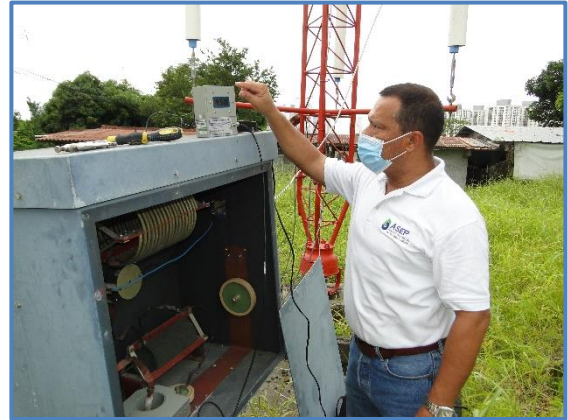
Fiscalización de Frecuencias – Inspección de Campo
