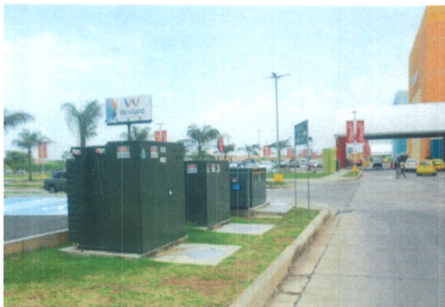
Para el Centro Comercial Westland Mall se instalaron 31 transformadores.
