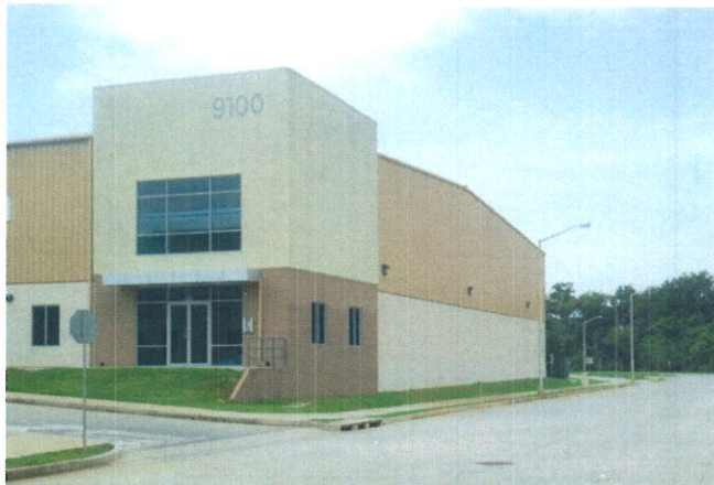
Para el proyecto de los Edificios #9100, #9095, #9097 se instalaron 6 transformadores de 1,000 kVA
