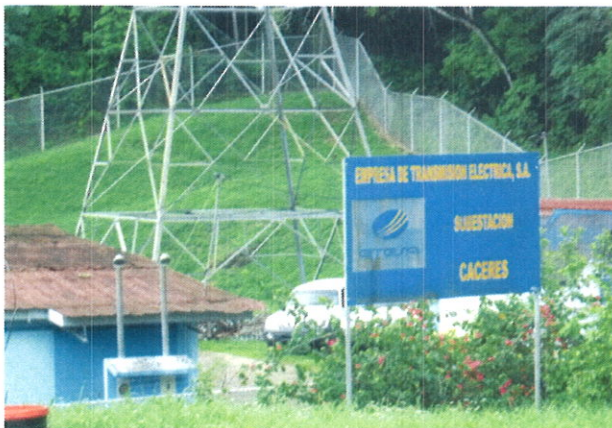
La subestación Cáceres fue el lugar de la inspección.
