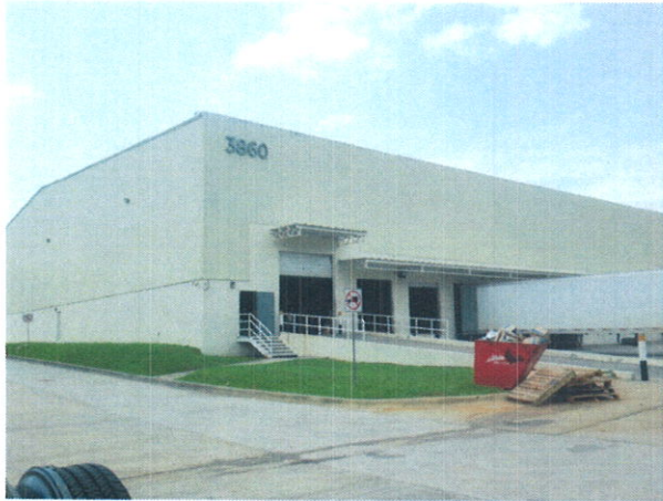
Complejo IBT. En este complejo se instalaron cuatro transformadores, para el edificio #3860.
