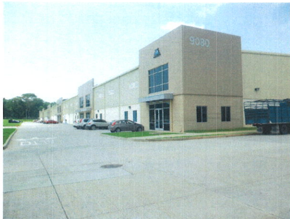
Vista del edificio #9080 de Panamérica Corporate Center.
