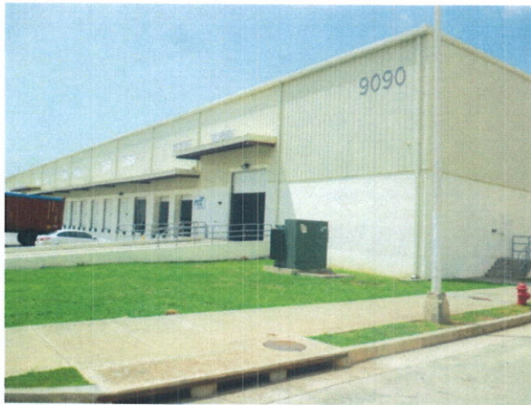
Transformador de 1,000kva instalado para el Edificio #9090.
