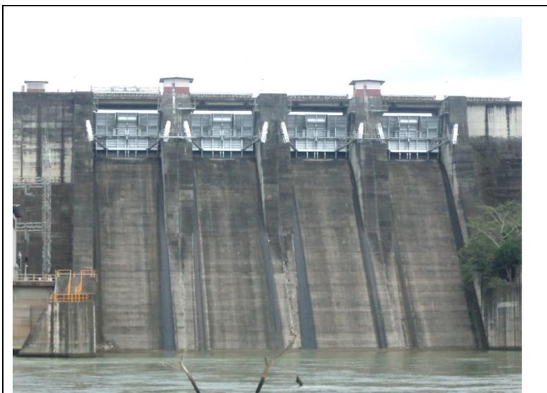
**Figura 1.** Vista de vertedero y compuertas de presa Bayano
